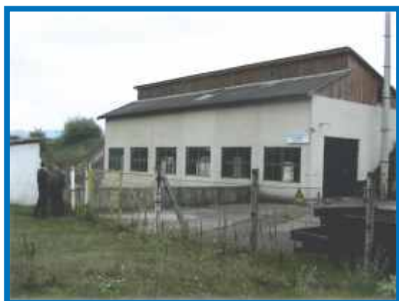
Înainte de modernizare
