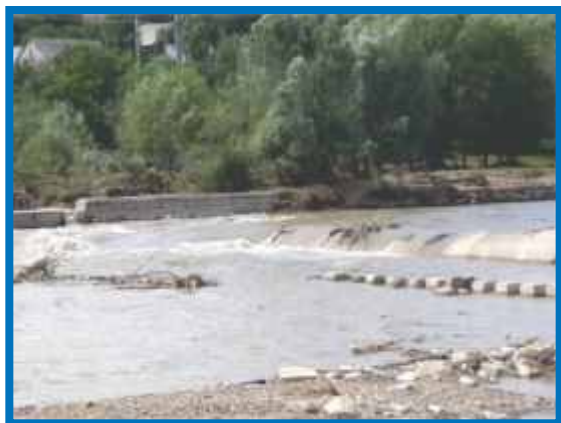
Înainte de modernizare
