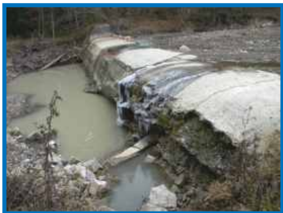
Înainte de modernizare
