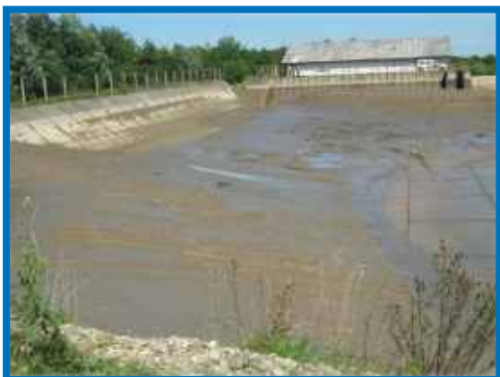
Înainte de modernizare
