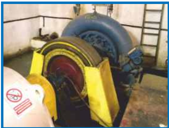
Înainte de modernizare
