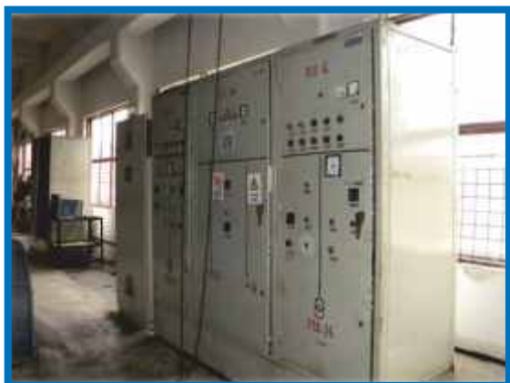
Înainte de modernizare
