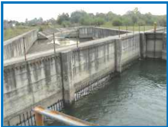
Înainte de modernizare
