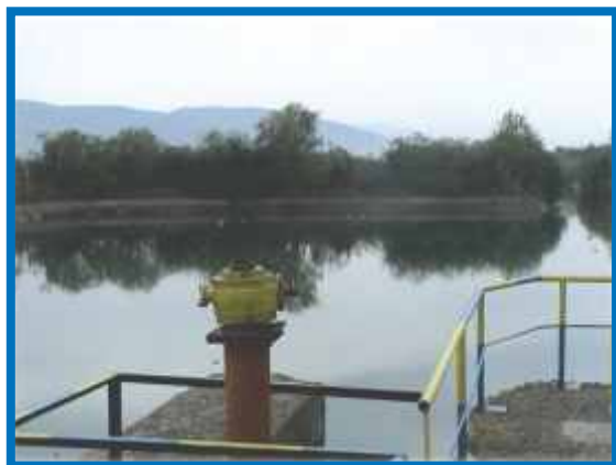
Înainte de modernizare
