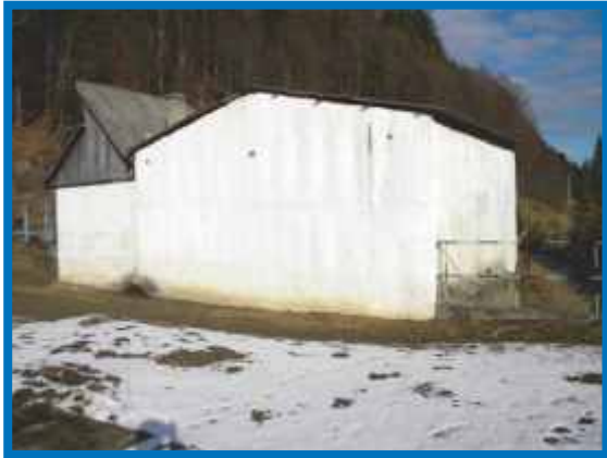
Înainte de modernizare
