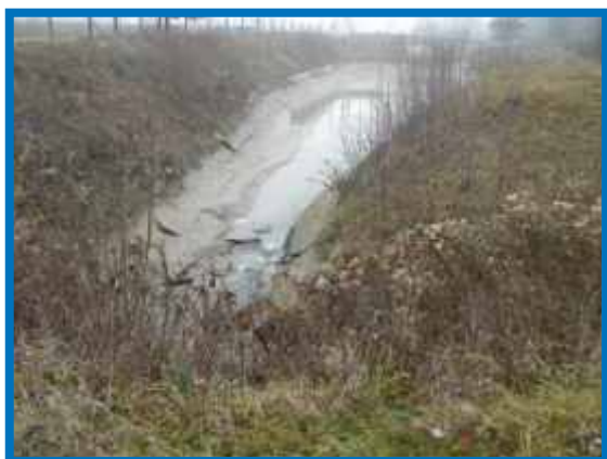
Înainte de modernizare
