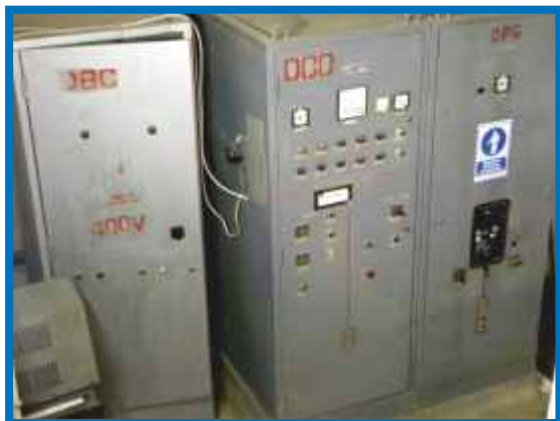
Înainte de modernizare
