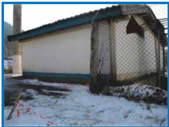
Înainte de modernizare
