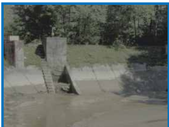
Înainte de modernizare
