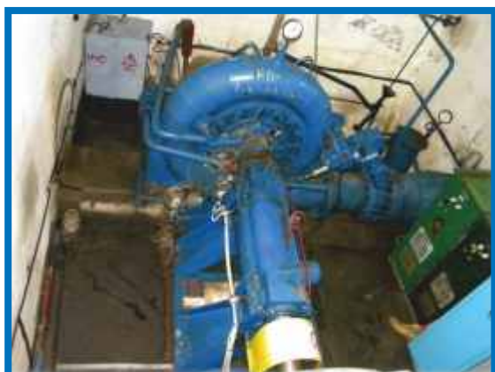
Înainte de modernizare
