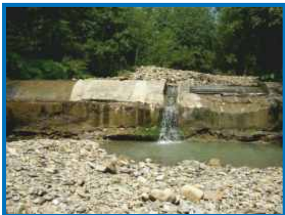
Înainte de modernizare
