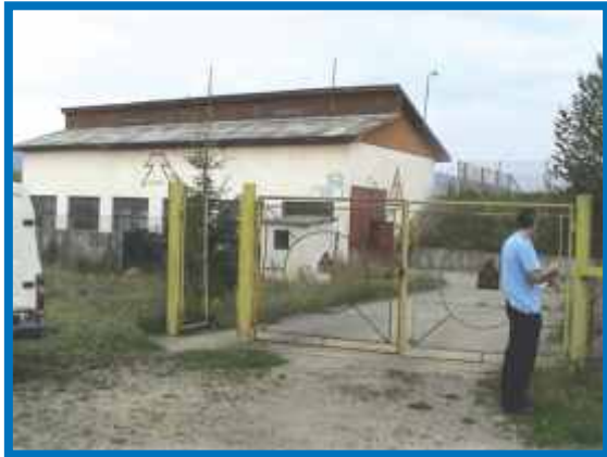
Înainte de modernizare
