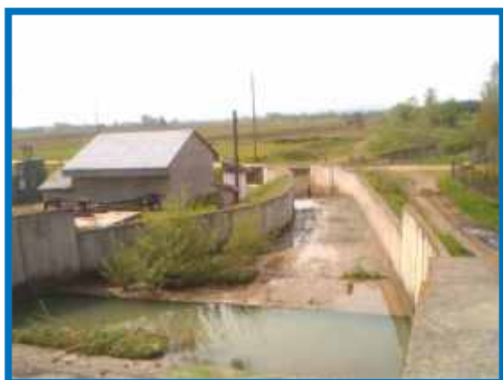
Înainte de modernizare
