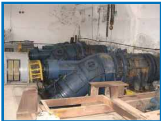
Înainte de modernizare
