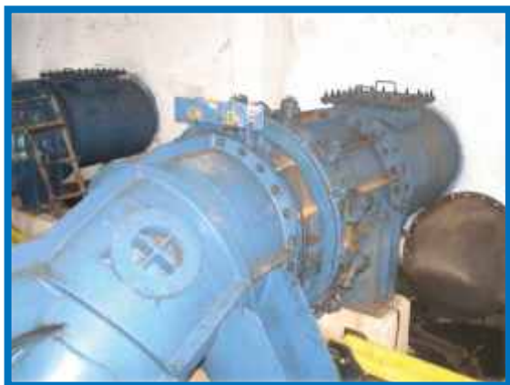
Înainte de modernizare
