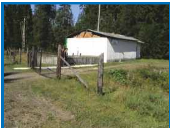
Înainte de modernizare
