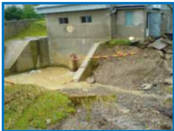
Înainte de modernizare
