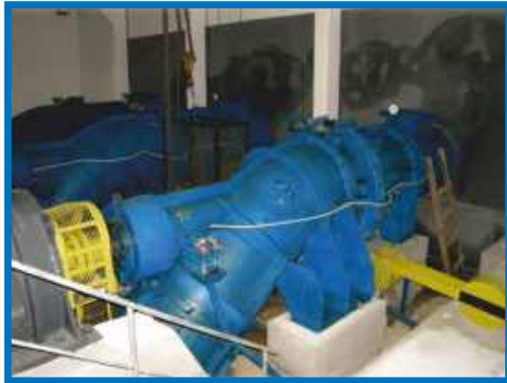
Înainte de modernizare
